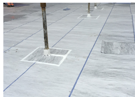
Tætning af detalje med HyDra Swelling Paste
