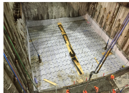
Færdig udlagt membran inden støbning
